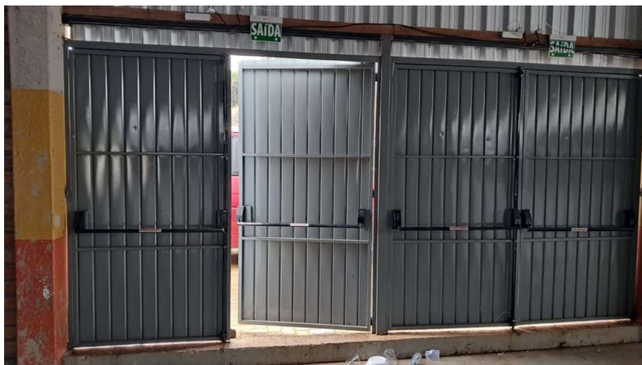
Figura 25 – Portão metálico existente com barra antipânico duplo, novas saídas de emergência deverá seguir mesmo padrão.
