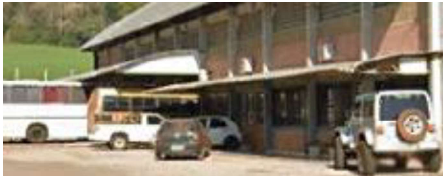
Figura 11 - Cobeto externo a receber forro em Drywall resistente ao fogo (RF).
