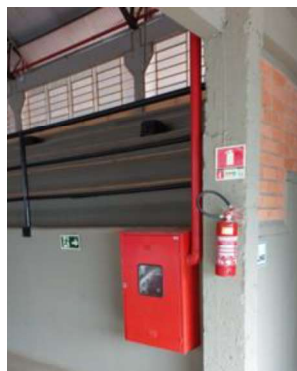
Figura 19 e 20 – Rede hidráulica e hidrantes existentes a serem reaproveitados.
