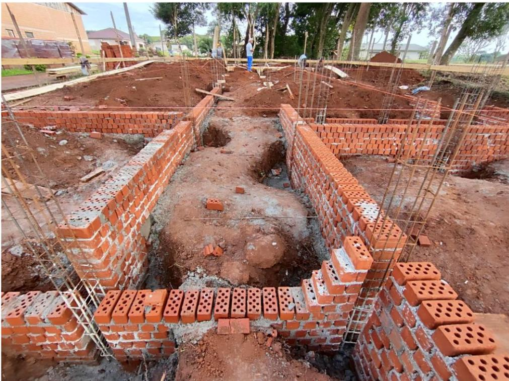
Foto 08 – Execução da alvenaria de nivelamento
