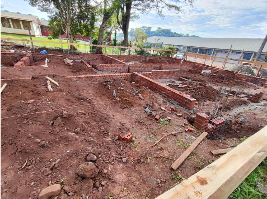
Foto 07 – Execução da alvenaria de nivelamento
