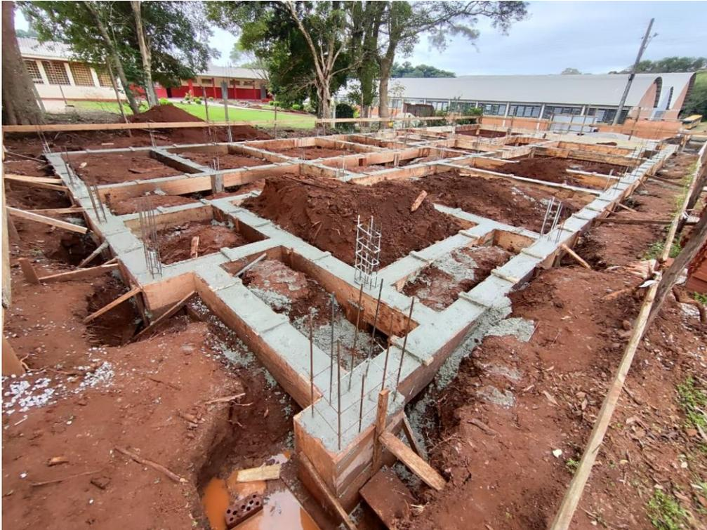
Foto 11 – Execução e concretagem das vigas baldrame
