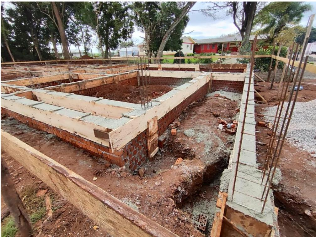
Foto 12 – Execução e concretagem das vigas baldrame
